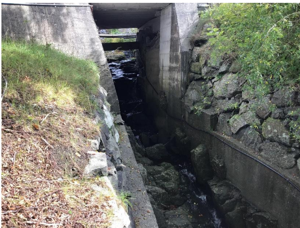
Figur 5. Flomoverløpet fra Krossvatnet, bilde tatt under Kvernvegen. Under Kvernvegen er det sprang på rundt 3 meter, med høy gradient og liten mulighet for oppstuvning av vann for spranggrop nedstrøms. Det er sannsynlig at løpet kan ha blitt bearbeidet eller endret, og at anadrom fisk tidligere kunne ta seg opp her. Overløpet er også en sannsynlig oppvandringsvei for glassål.
