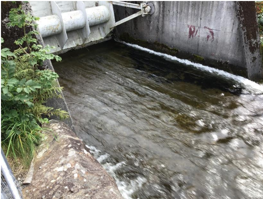
Figur 6. Når kraftverket er i drift slippes det 10,5 m 3 /s gjennom luka ut av Bjørheimsvatnet (se plassering av luka i figur 2). Dette gir en svært høy vannhastighet over den flate betongbunnen. Luka utgjør dermed et vandringsstengsel når den er stengt og et svært vanskelig vandringshinder når den er åpen (trolig stengsel).
